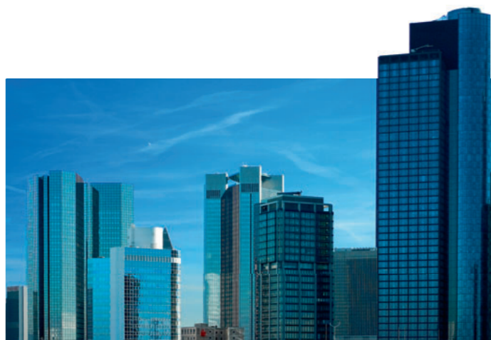
Bürogebäude / Office buildings
